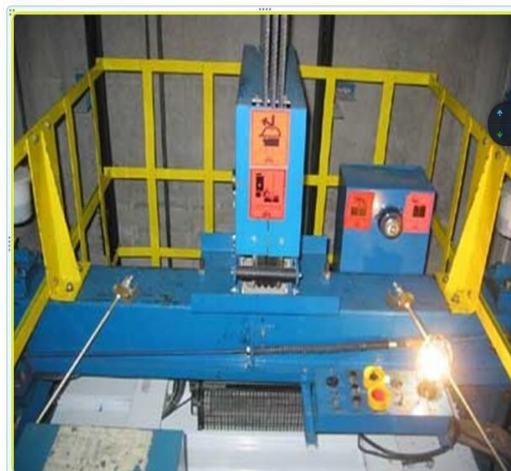
图 3-5 轿顶结构
